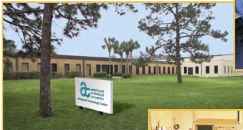
▲ 高级技术中心, 生产厂房, 佛罗里达州杰克逊维尔市。
