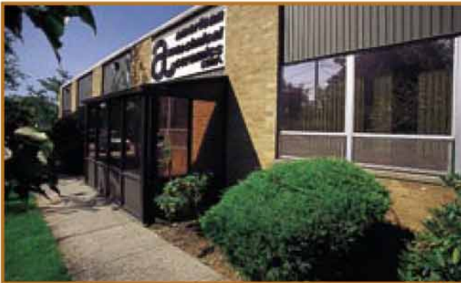
▲ ATC纽约厂房占地约90,000平方英尺
